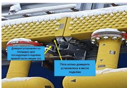
Рисунок 2. Установка домкрата на приспособление-съёмную площадку
